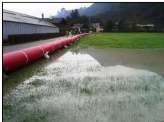
Da die Aufräumungs- bzw. Wiederherstellungsarbeiten am Bachbett noch nicht abgeschlossen werden konnten, musste am Charlottenhüttenweg unser mobiler Hochwasserschutz (Floodtubes) aufgebaut werden, da weiterer Starkregen angekündigt wurde. Dieser hätte die dort befindlichen Objekte massiv gefährdet, entgegen der Vermutungen besserte sich jedoch die Wetterlage.
